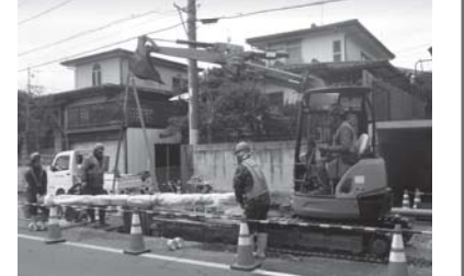
▲老朽管更新工事
