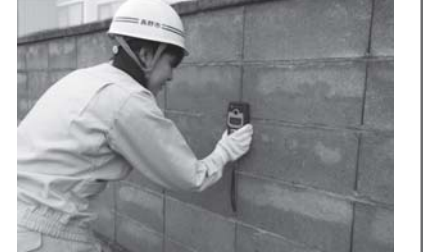
▲ブロック塀調査
